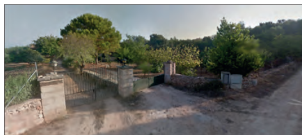
IMATGE 40. Fotografia de l'any 2022 d'una zona dels establits «urbanitzats» de Rafalet. Parcel·les amb aigua corrent, electricitat i telèfon.
