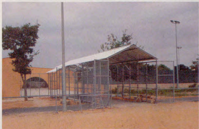
A Pina s'ha instal·lat un túnel per protegir els jugadors.
