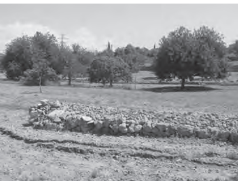
PARAT. Parat en una finca vora el torrent de Son Capellà, a la zona de Son Lloret, a la banda de ponent del nucli urbà d'Algaida. Amb aquestes construccions de pedra seca s'aconseguien dos objectius alhora: treure les pedres de dins les finques, que podien dificultar-ne el conreu, i impedir que l'aigua corrent s'endugués la terra.
