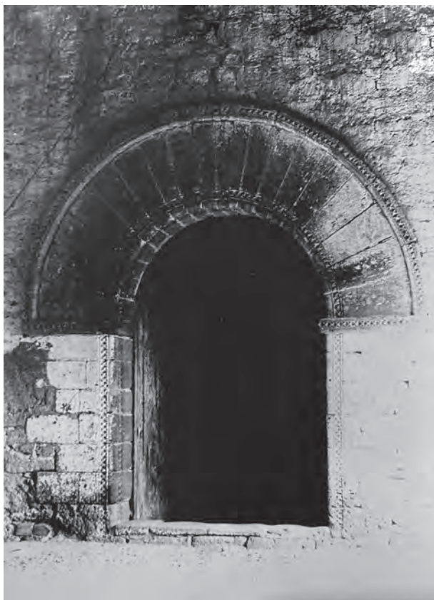
FIG. 60. ESSLÉSIA DE LA MARE DE DÉU DE LA PAU DE CASTELLITX. Text original: «Primitivo portal del oratorio, de estilo románico [sic]. Mide 3 metros de altura por 2,60 de ancho».
