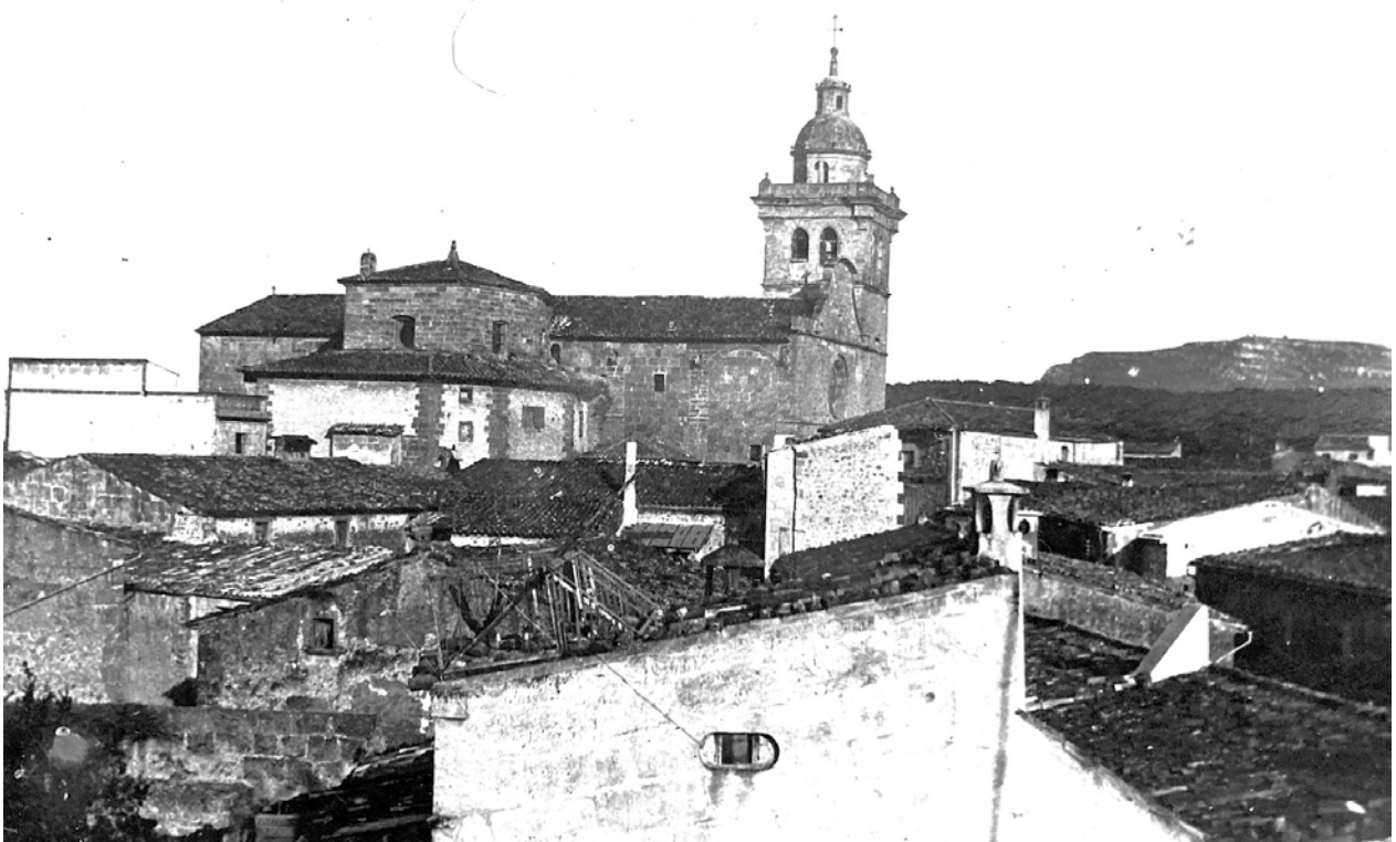
FIG. 4. ESSLÉSIA PARROQUIAL, PART EXTERIOR. Església de sant Pere i sant Pau d'Algaida . Text original del peu de foto que apareix al treball: «Exterior de la iglesia y torre-campanario vistos desde la azotea de la calle situada en la calle de la Roca nº 43».
