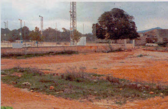
PISTES DE TENNIS: La comissió de Govern del passat 21 de setembre aprovà l'adjudicació de les obres a l'empresa ORTIZ S.A. L'aportació municipal és del 30%, mentre que el Consell de Mallorca n'aporta la resta, concretament 15.181.322 pessetes.
