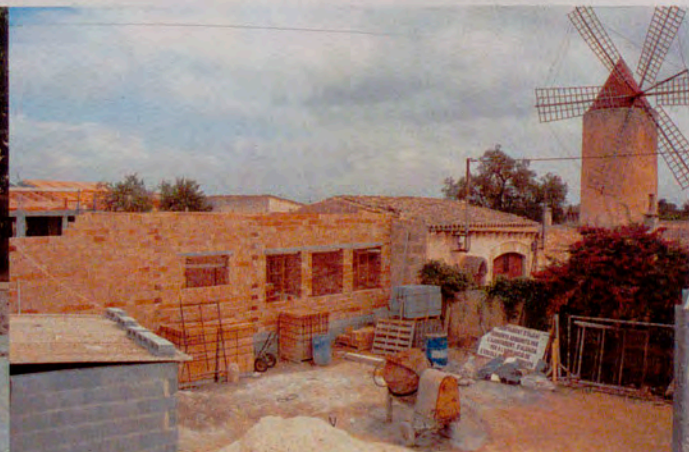
ESCOLETA MUNICIPAL: Les obres de l'escoleta són les que estan més avançades de totes i, poc a poc, el futur edifici comença a agafar forma.
